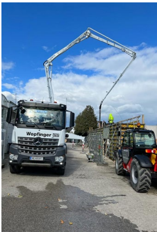
Betonierarbeiten bei der Einstellhalle
