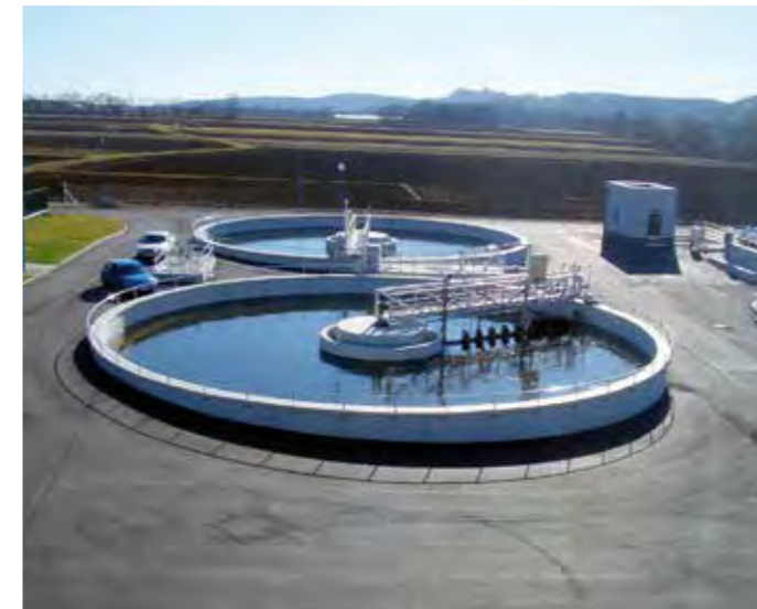
Kläranlage Bad Gleichenberg
